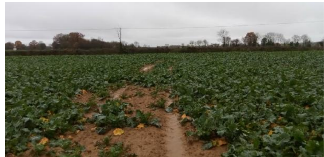
Vue 8 – Future plateforme et fondation
